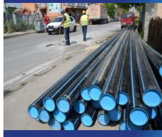
Изградња водовodne и канализационе мреже у селима
